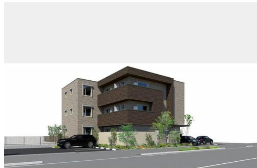
※写真は完成予想図です パースは実際の図面をもとに描き起こしたイメージで、実際のものとは異なる場合があります
